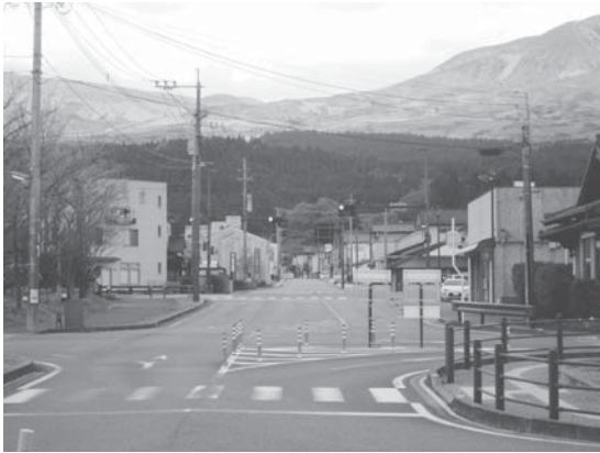
電柱地中化を予定している阿蘇駅前交差点
