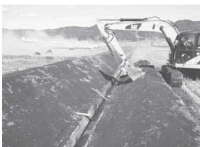
多面的機能支払交付金を活用した水路整備
