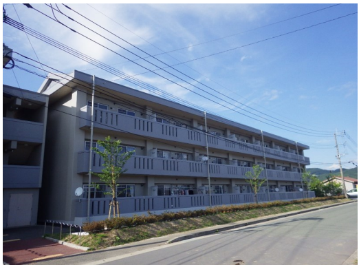
熊本地震で被災し、住戸が滅失した人を入居対象とした災害公営住宅（新小里団地4号棟）
