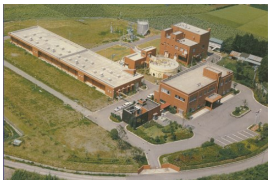
下水道処理施設
