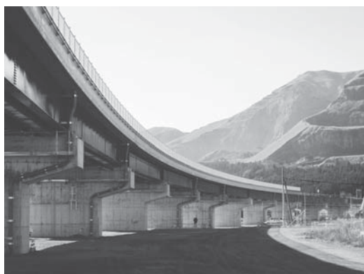
建設中の国道57号北側復旧ルート
