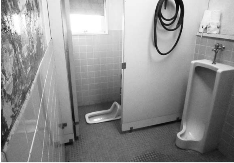
改修予定の山田体育館トイレ
