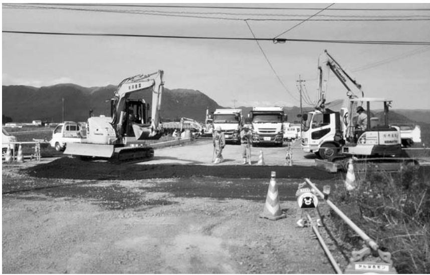
阿蘇中部広域農道整備事業工事現場
