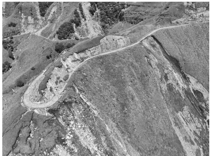
被災した狩尾幹線道
