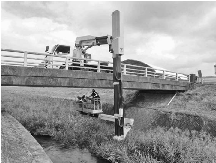
橋梁点検車による橋の点検
