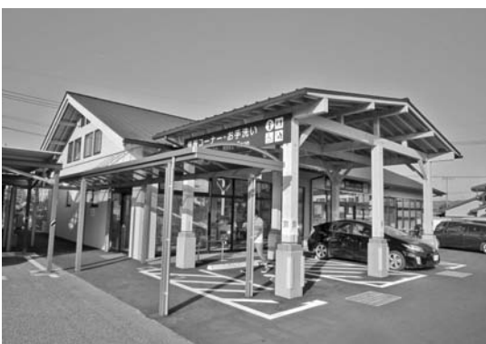
道の駅阿蘇の新設トイレ
