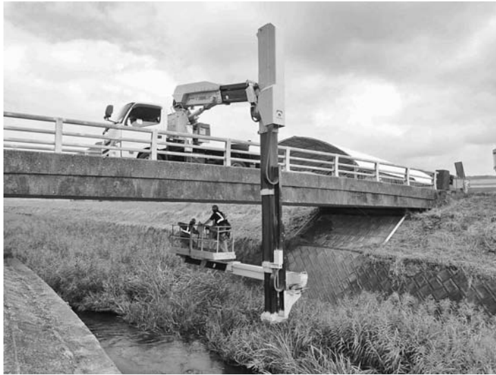
橋梁点検車による橋の点検
