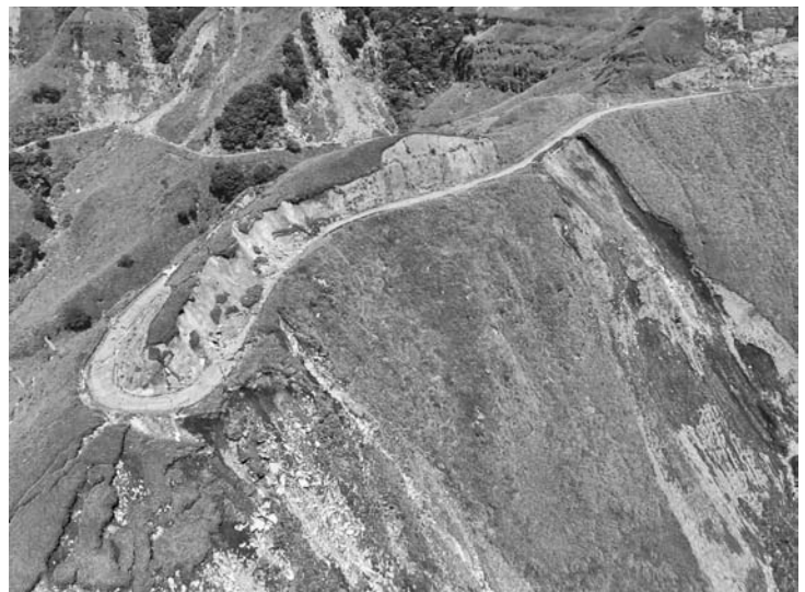
被災した狩尾幹線道
