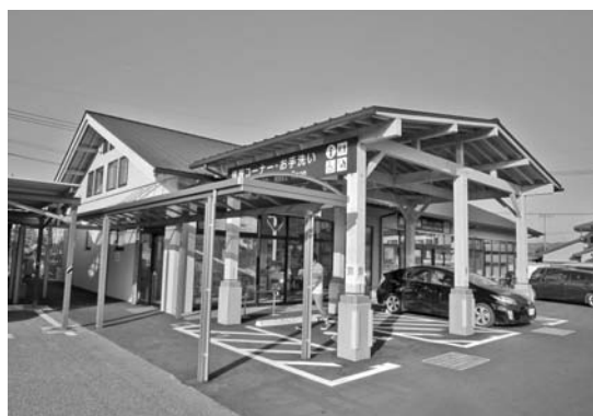
道の駅阿蘇の新設トイレ
