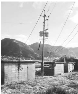
用水機場全景
