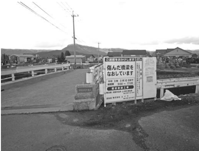
工事中の成川新川橋
