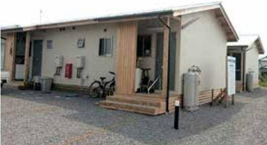
市内5カ所に仮設住宅を整備
