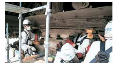
割裂した箇所へ接着剤を注入するなど慎重に補修し、震災前の姿へ
