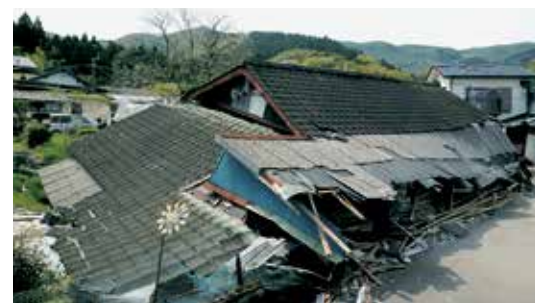
崩壊した民家(車庫)
