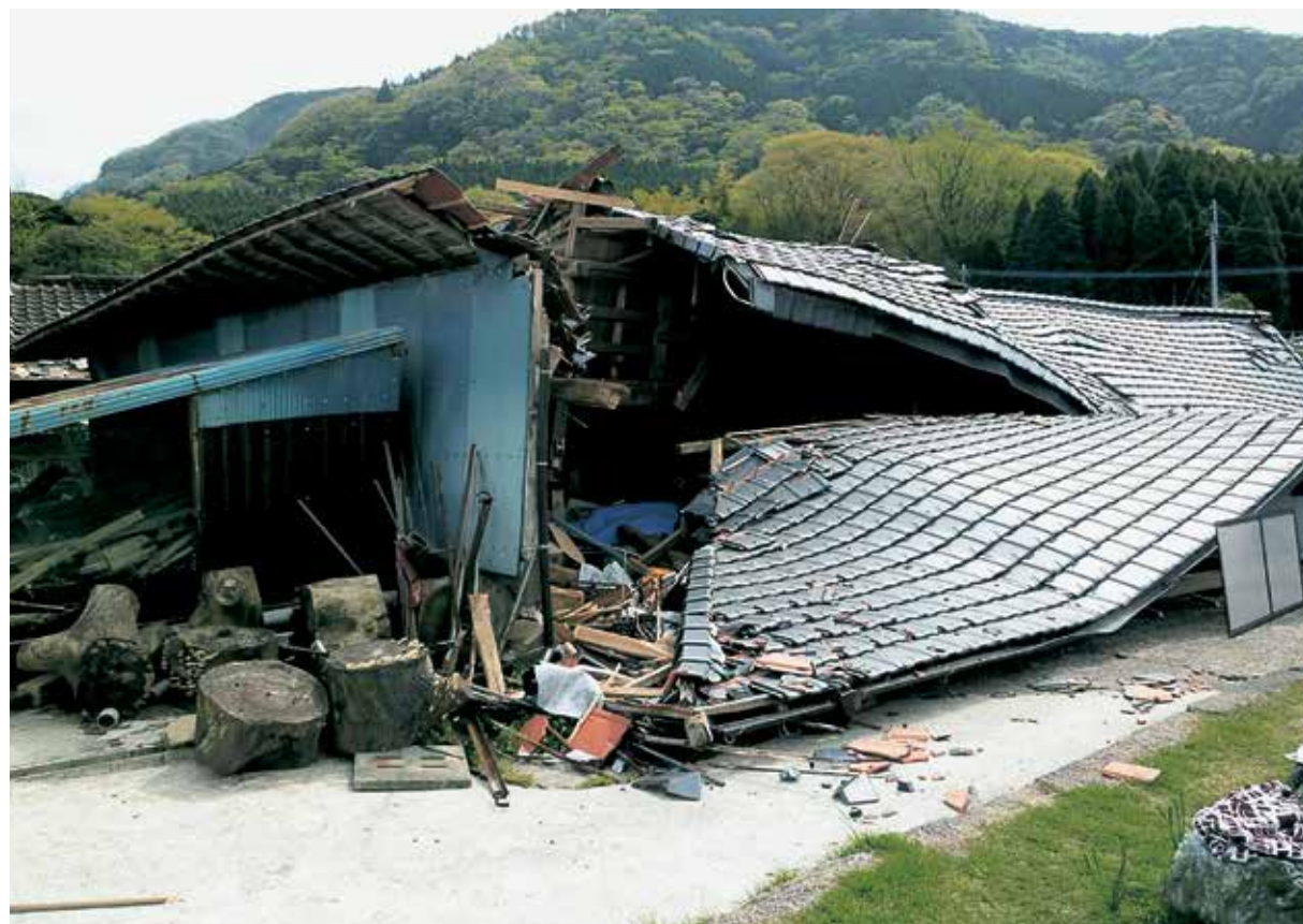
崩壊した納屋(車帰)
