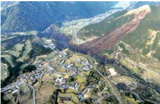
山腹が崩壊し阿蘇大橋も落橋した
