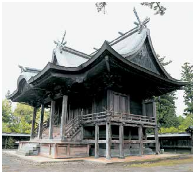
一の神殿 天保11年(1840)建立。平成31年3月復旧完了
