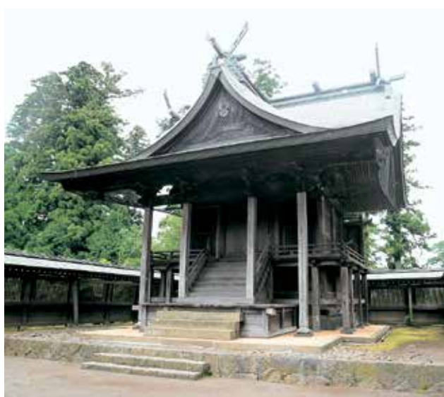
三の神殿 天保14年(1843)建立。平成31年3月復旧完了
