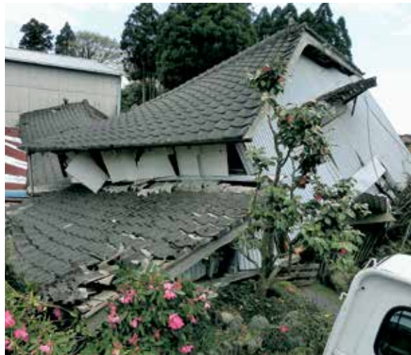
崩壊した納屋(中通)
