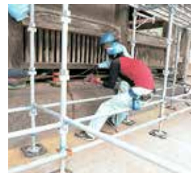
柱の傾斜直し
