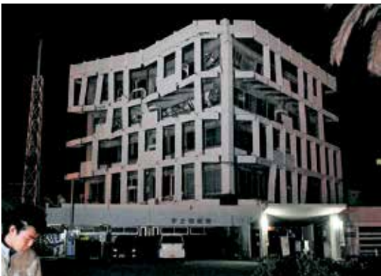
鉄筋コンクリート5階建ての宇土市役所も大きな被害を受けた
