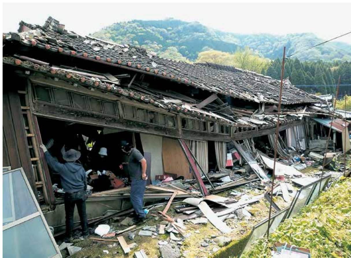
崩壊した民家(車帰)
