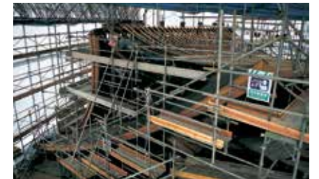
楼門解体状況を公開
