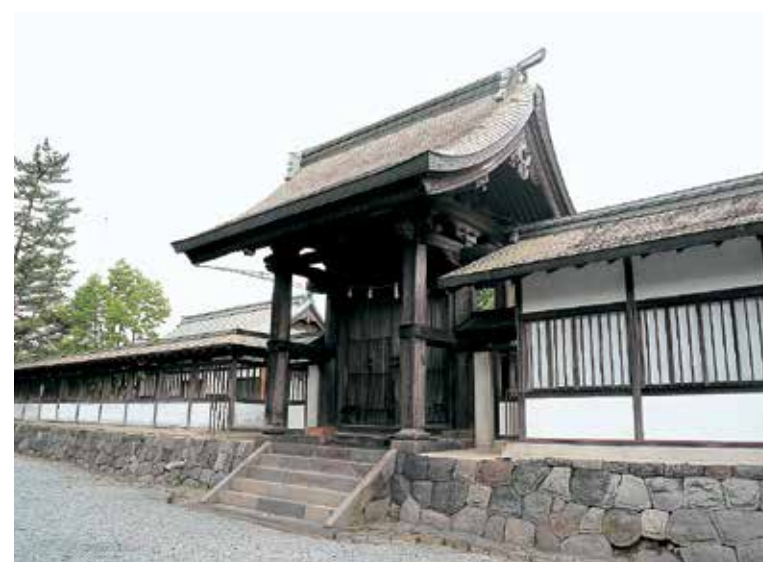
還御門 嘉永2年(1849)建立。平成31年3月復旧完了
