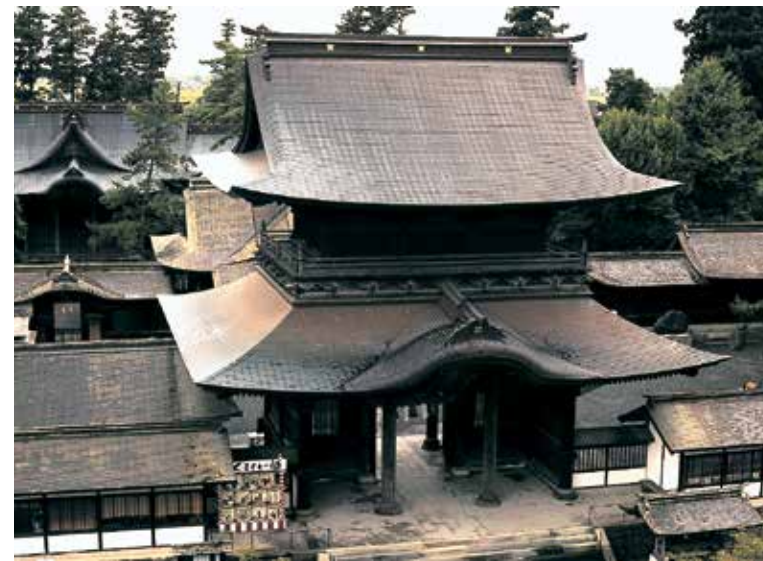
倒壊前の楼門 嘉永3年(1850)建立。令和5年復旧完了予定
