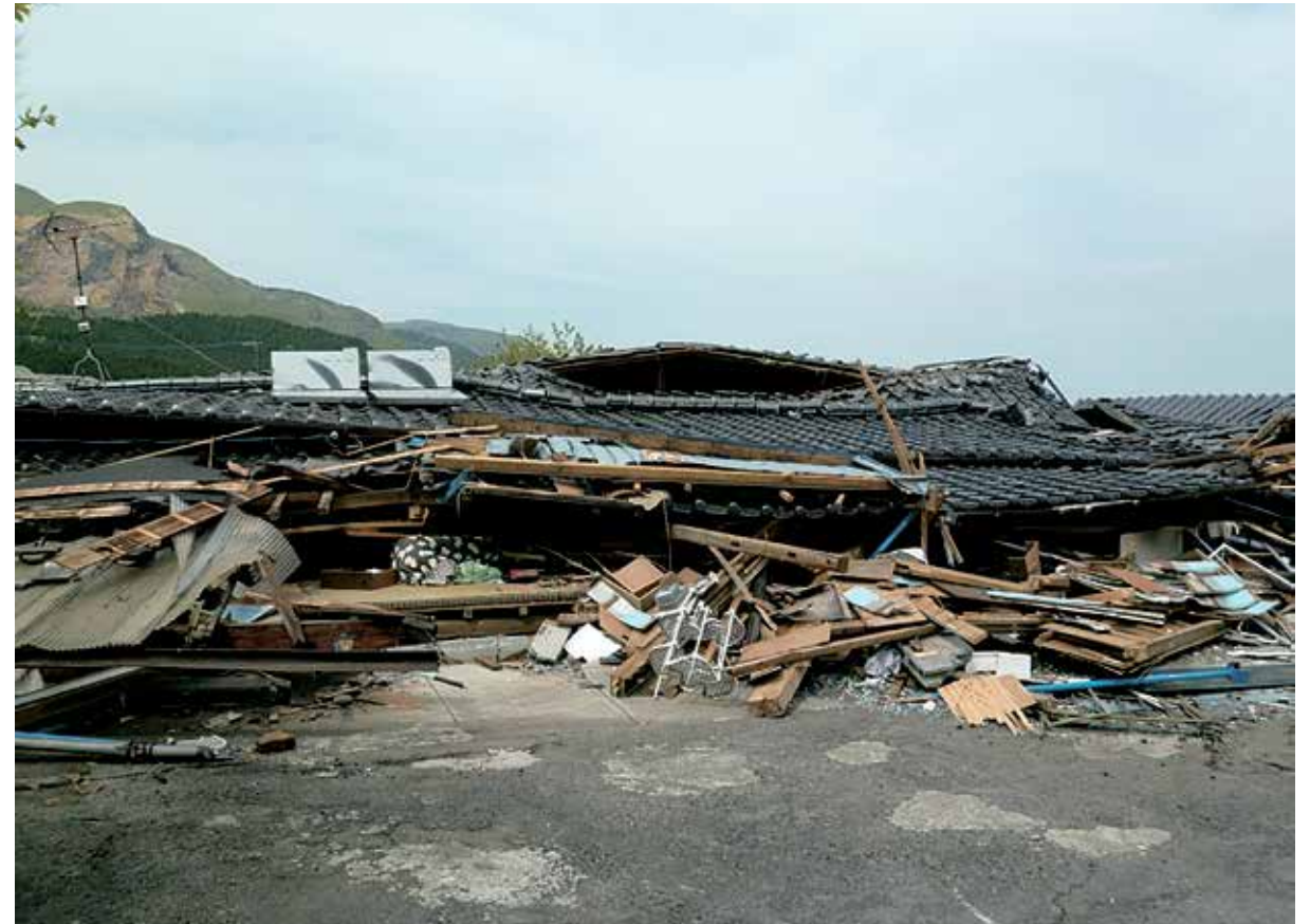
崩壊した民家(車帰)
