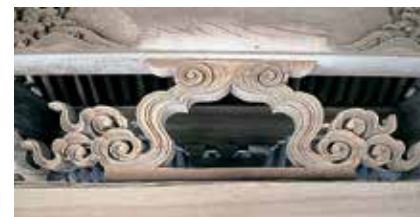
だぼ 割れたところに太枅を仕込み接着剤で接合
