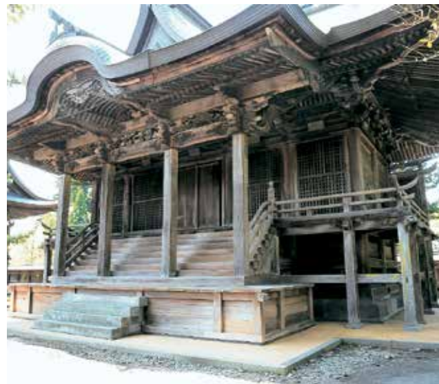
二の神殿 天保13年(1842)建立。平成31年3月復旧完了
