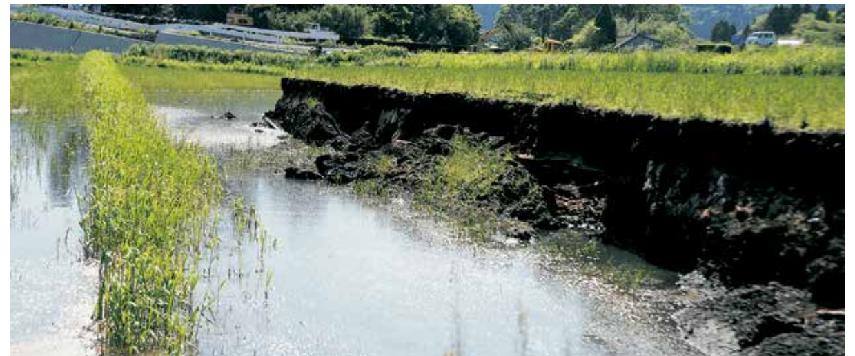
農地の大きな陥没により作付にも影響が及んだ
