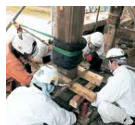
柱の建て起こし
