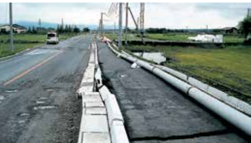
導水管仮設状況(阿蘇西小学校前)
