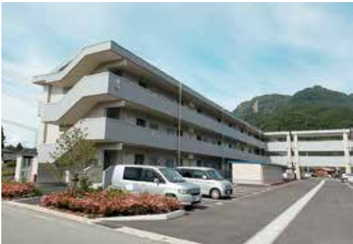
災害公営住宅(新小里団地)
