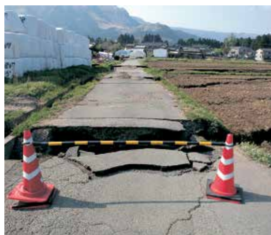
市道乙姫甲賀無田1号線 (狩尾1区)
