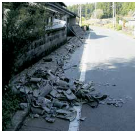
道路に崩れ落ちた瓦(狩尾)
