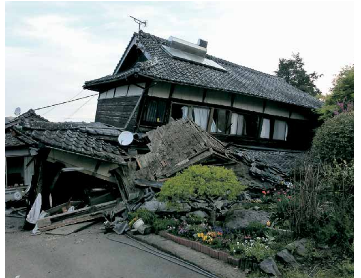
1階部分がつぶれた民家(中通)
