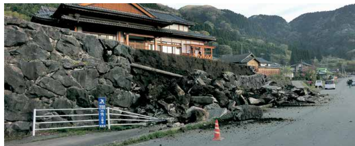
崩落した石垣(中通)
