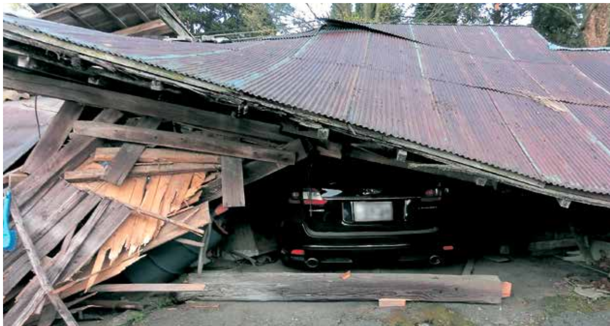
崩壊した納屋(中通)
