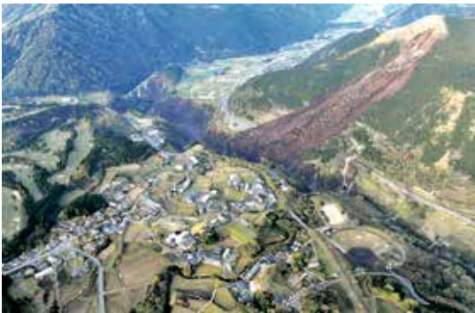
山腹が崩壊し阿蘇大橋も落橋した
