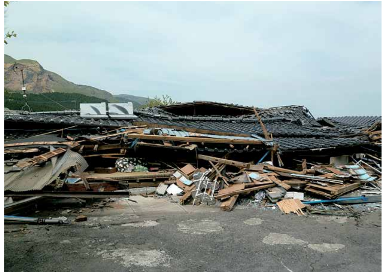
崩壊した民家(車帰)
