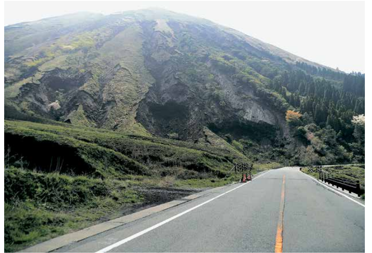
杵島岳の斜面崩壊(阿蘇登山道路から)
