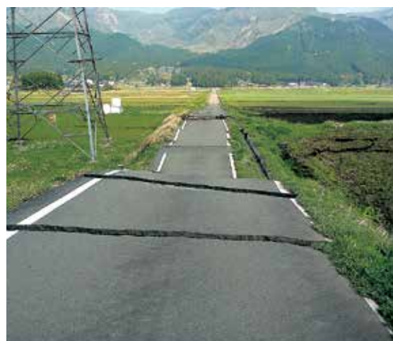
市道阿蘇西小学校黒川堤防線 (的石)
