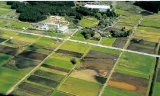
帯状の陥没や地割れ(狩尾)
