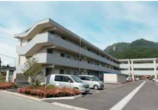
災害公営住宅(新小里団地)
