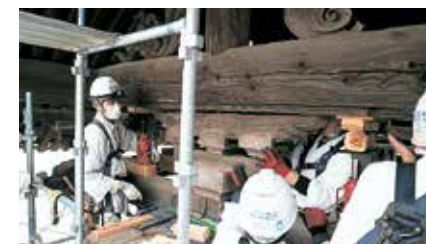
割裂した箇所へ接着剤を注入するなど慎重に補修し、震災前の姿へ
