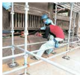
柱の傾斜直し
