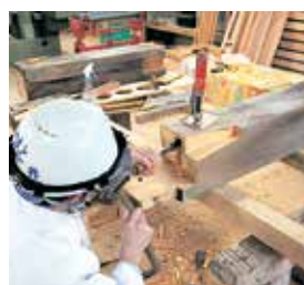
破損部の補修
