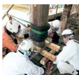
柱の建て起こし
