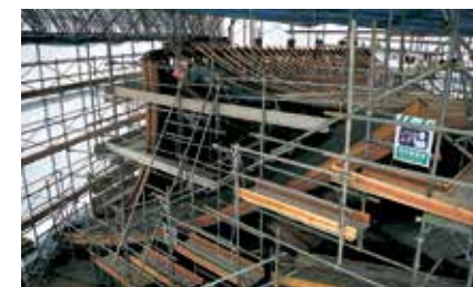
楼門解体状況を公開
