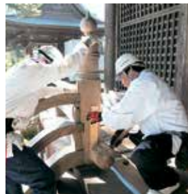
高欄のずれ直し
