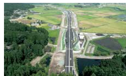
完成した北側復旧ルート阿蘇側坑口付近
