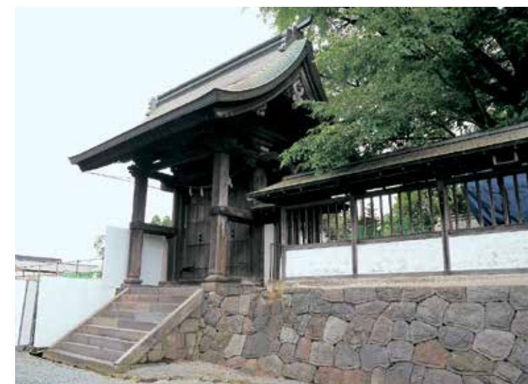
神幸門 嘉永2年(1849)建立。平成31年3月復旧完了
