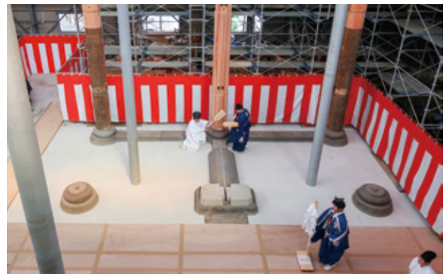
素屋根の中で立柱の儀式を執り行う工事関係者
