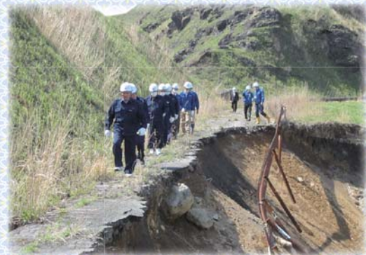
市道狩尾幹線現況調査
