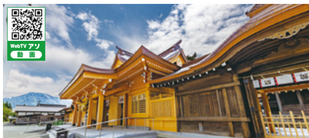
完成した拝殿
