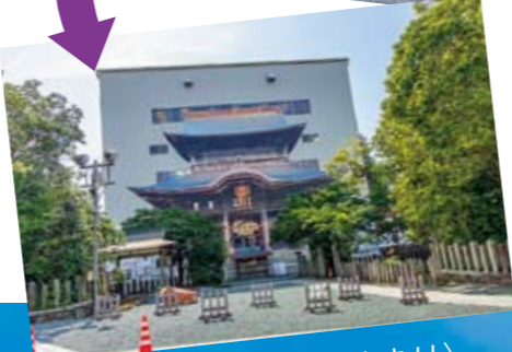
楼門も修復中!!
