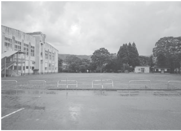
阿蘇体育館横の内牧仮設住宅跡地
