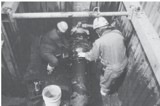
水道管の布設替工事
