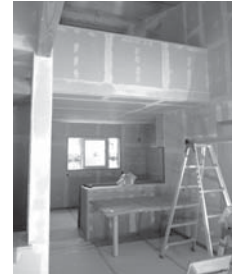
建築中の住宅
