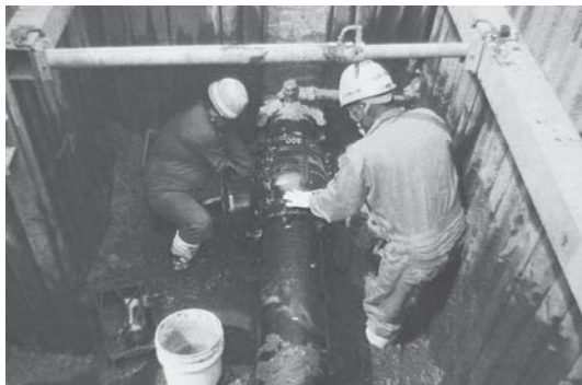
水道管の布設替工事
