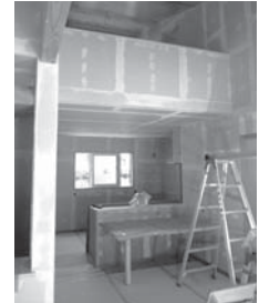
建築中の住宅
