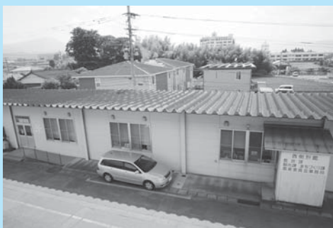
市役所本庁西側別館屋根改修工事
