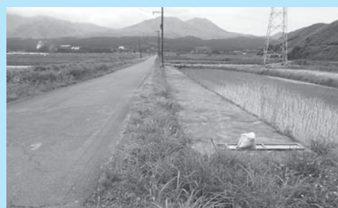
あびか横 上西黒川成川線 (施工中)
