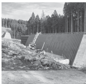
工事が進む西湯浦川1砂防工事
