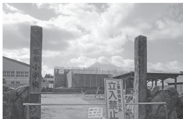
坂梨保育園移転工事の現場
