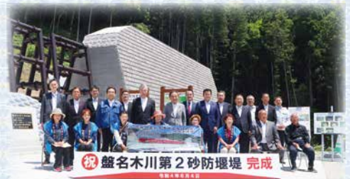
盤名木川第2砂防堰堤完成見学会
