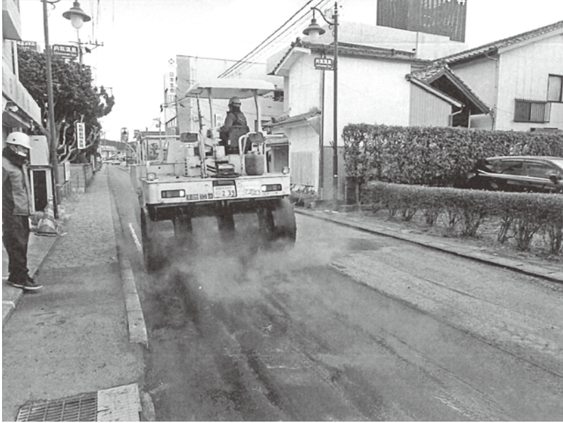
道路維持施工状況
