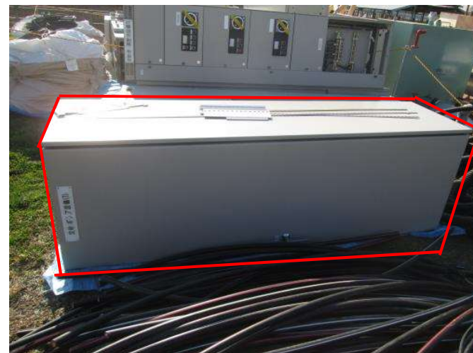
写真:撤去状態(撤去材)
