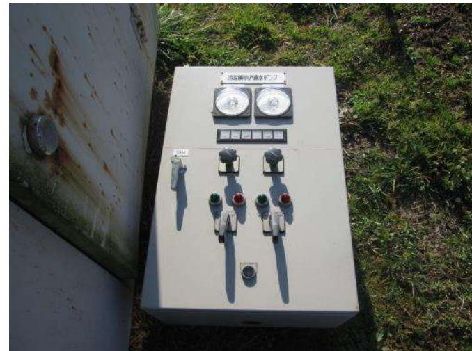
写真:撤去状態(撤去材)
