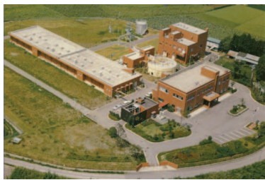
下水道処理施設
