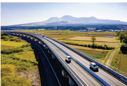
国道57号北側復旧道路
