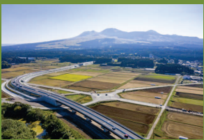
国道57号北側復旧道路
