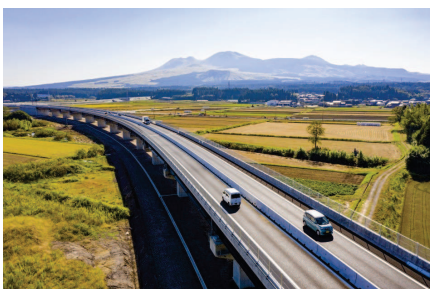
国道57号北側復旧道路
