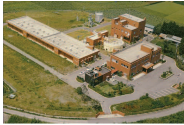
下水道処理施設
