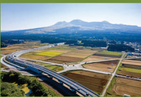
国道57号北側復旧道路
