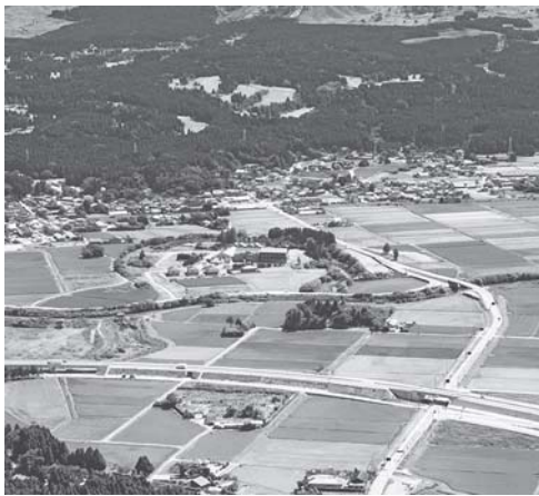
北側復旧ルート（車帰IC付近）
