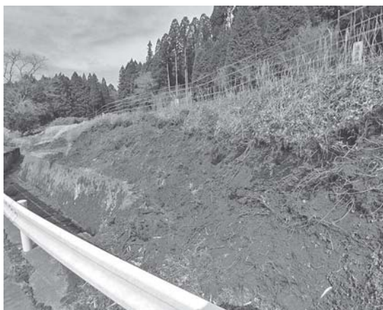
イノシシによる被害状況
