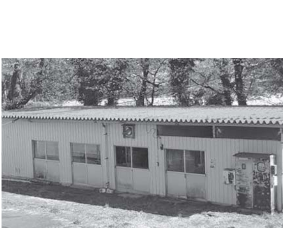
波野総合グラウンド管理棟
