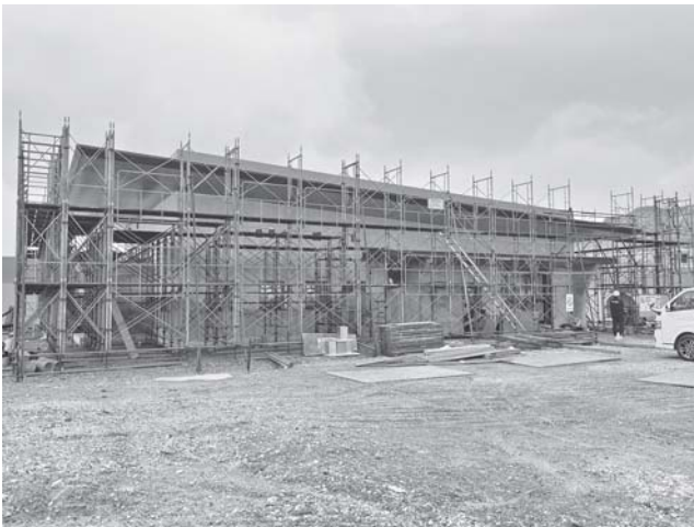
整備が進む「阿蘇山火口二次避難休憩施設」
