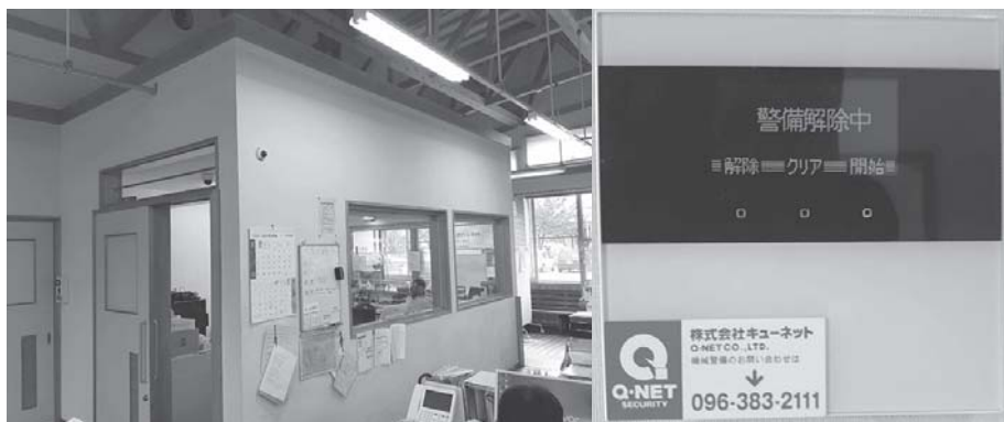
夜間警備用カメラが設置された内牧支所
