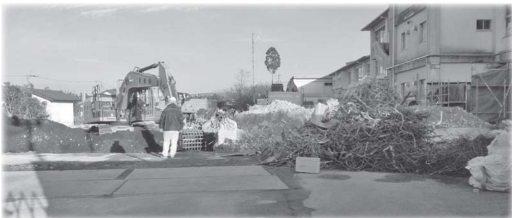
解体を終えた阿蘇小学校体育館
