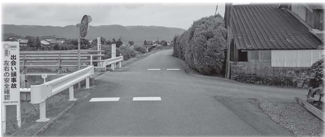
交通安全対策 (補助停止線)
