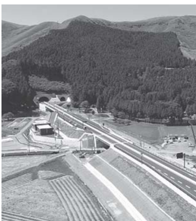
北側復旧ルート（二重の峠トンネル）
