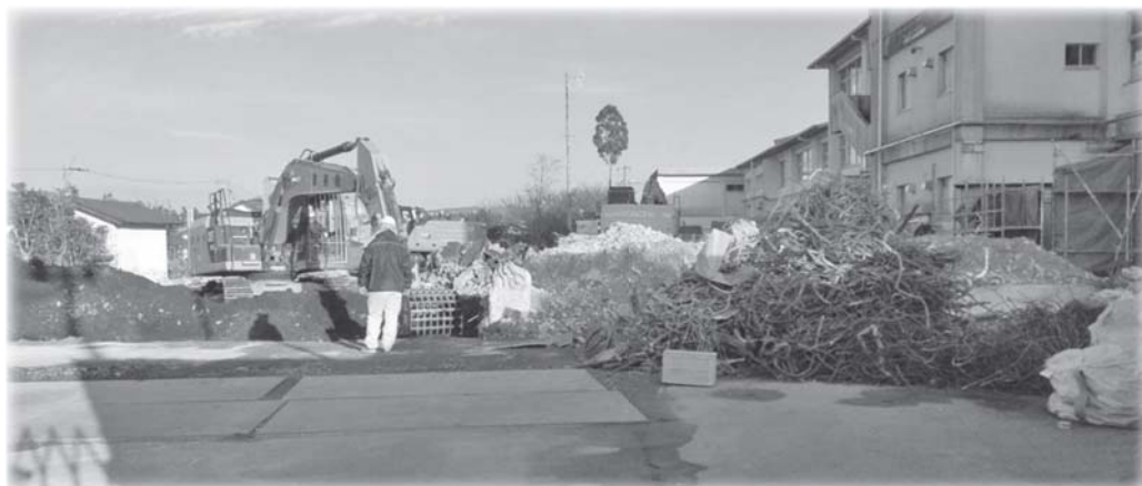
解体を終えた阿蘇小学校体育館
