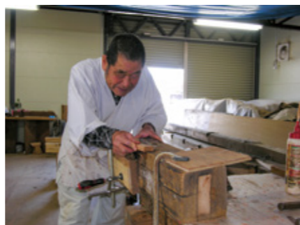
部材の補修作業をする下村さん
