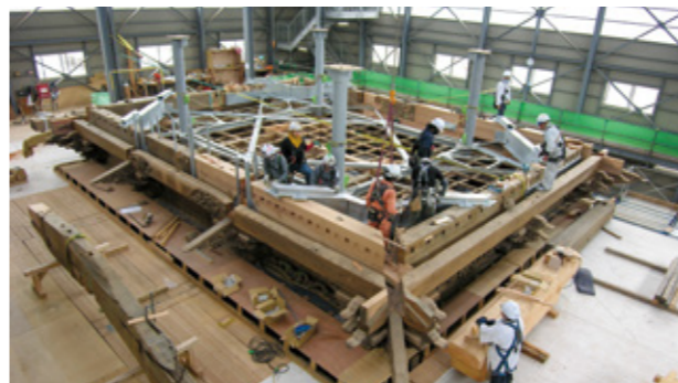
耐震補強も施された(右図赤部分)
