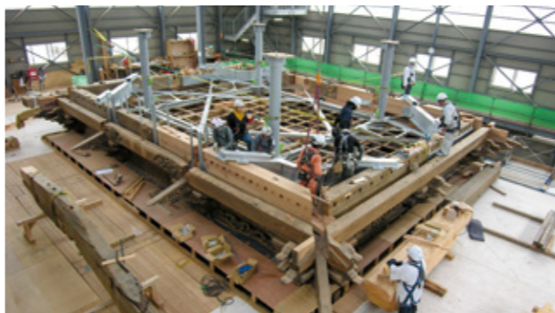
耐震補強も施された(右図赤部分)
