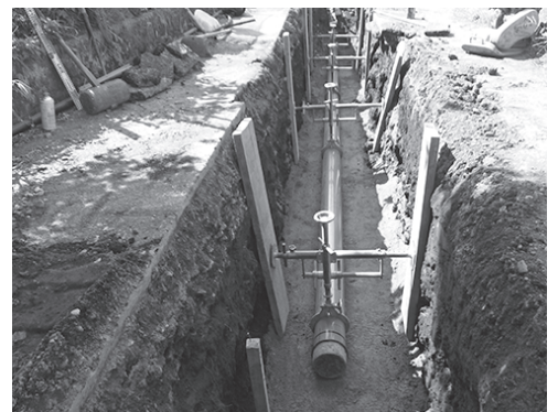
下水道工事（南黒川地区）
