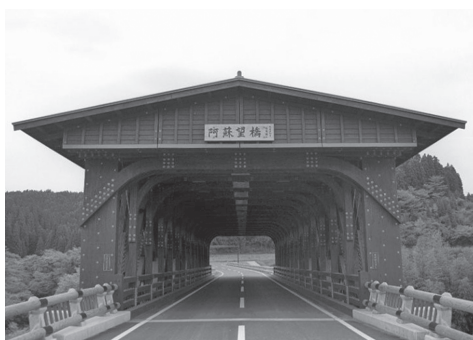
平成11年完成当時の「阿蘇望橋」
