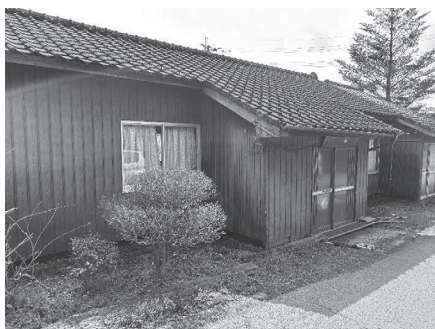
改修等が望まれる地区集会所
