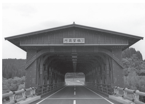
平成11年完成当時の「阿蘇望橋」
