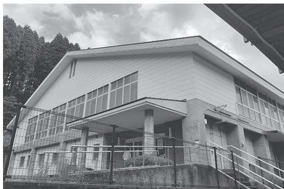
波野中学校屋内運動場
