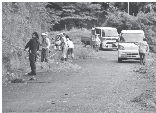
道路の除草作業（波野地区）
