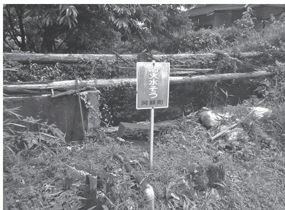
撤去予定の防火水槽
