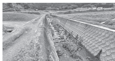
堆積物が撤去された河川
