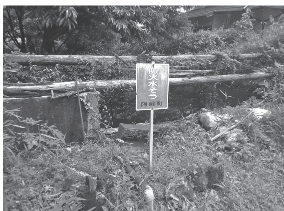
撤去予定の防火水槽
