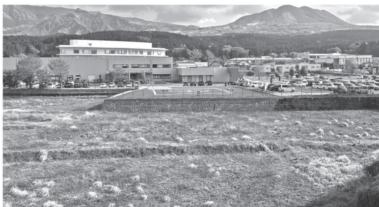
拡張予定の医療センター駐車場
