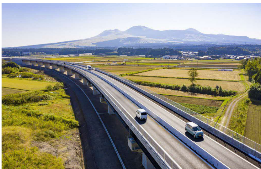
国道 57 号北側復旧道路
