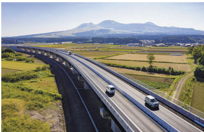
国道 57 号北側復旧道路
