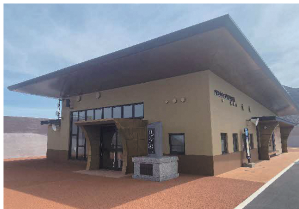
阿蘇山火口二次避難休憩施設
