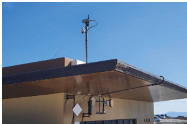
▲二次避難休憩施設に設置されたNTTドコモの通信設備
